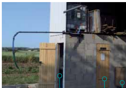
Local hygiène et rangement Local de stockage produits Stockage de bidons et emballages vides
